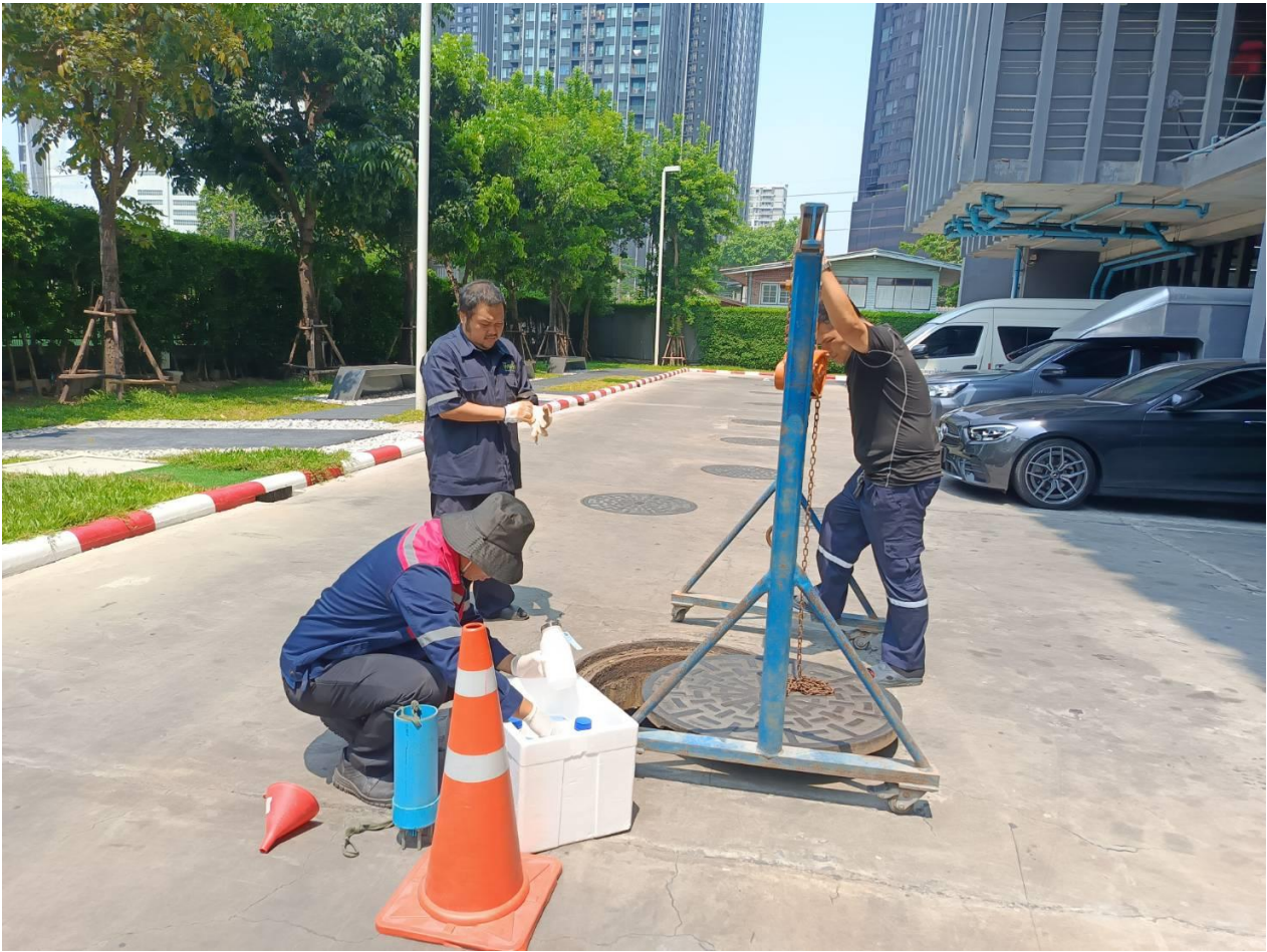
รูปที่ 3.5-1การเก็บตัวอย่างคุณภาพน้ำทิ้ง
